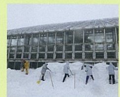
温室の側面に積もった雪を取り除く
