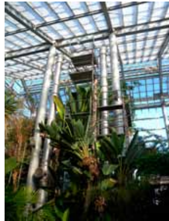
熱帯雨林植物室に設置された足場
