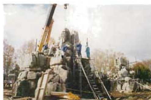
「石林の石」の組立て作業
